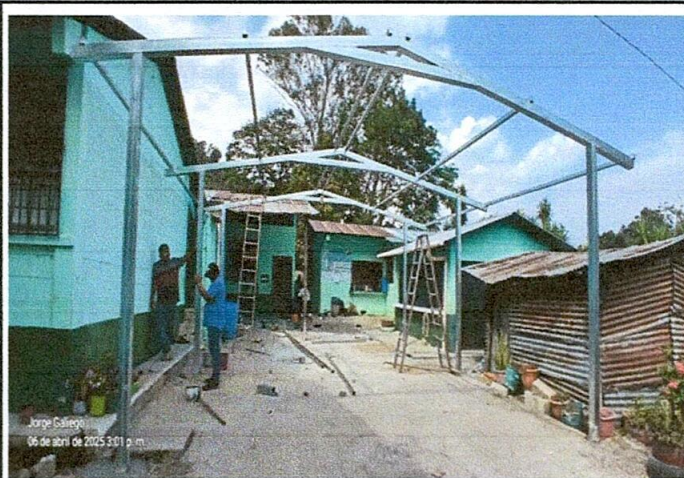
Foto 2: Cubierta de Lamina
